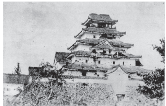
図1 崩壊寸前の鶴ヶ城。
