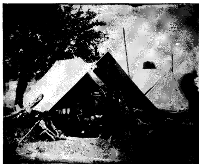
USMTCs電信士用の仮設テントと蓄電池用輜重車
